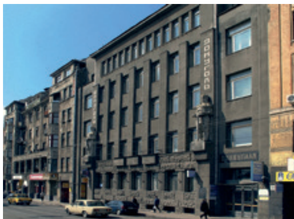
Здание треста Донуголь в Харькове
