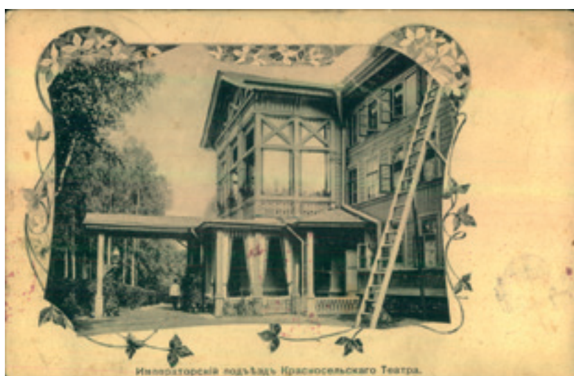
Фотооткрытка «Императорский подъезд Красносельского театра». Издательство фотографа Александра Оцуна. Начало XX века. ГМИ СПб
